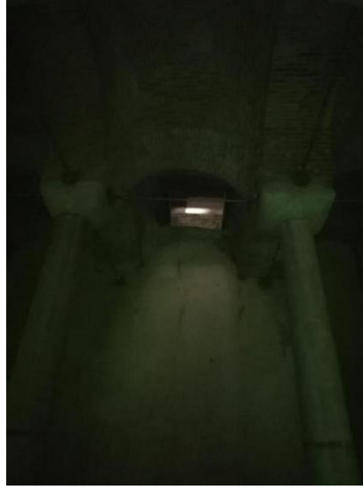
Fotoğraf 1. Yerebatan Sarnıcı'nda suyu tahliye etmek için açılmış delik örneği
